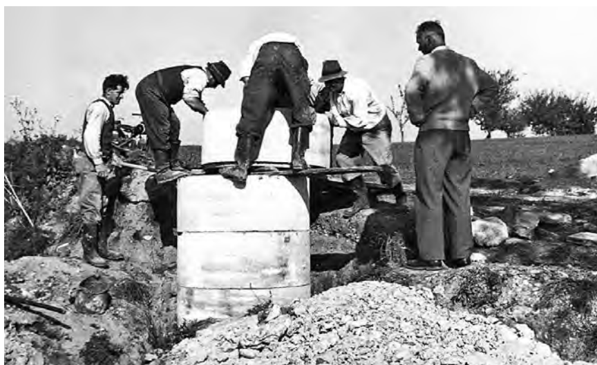
Abb. 7: Arbeiten an der Infrastruktur der neuen Heimat
